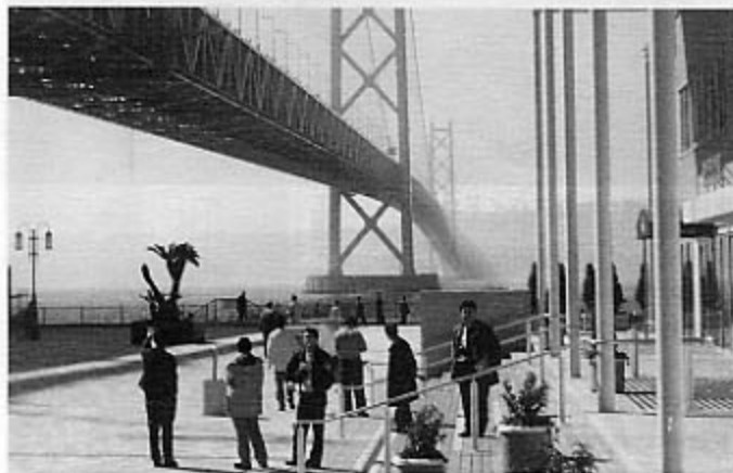
明石海峡大橋
