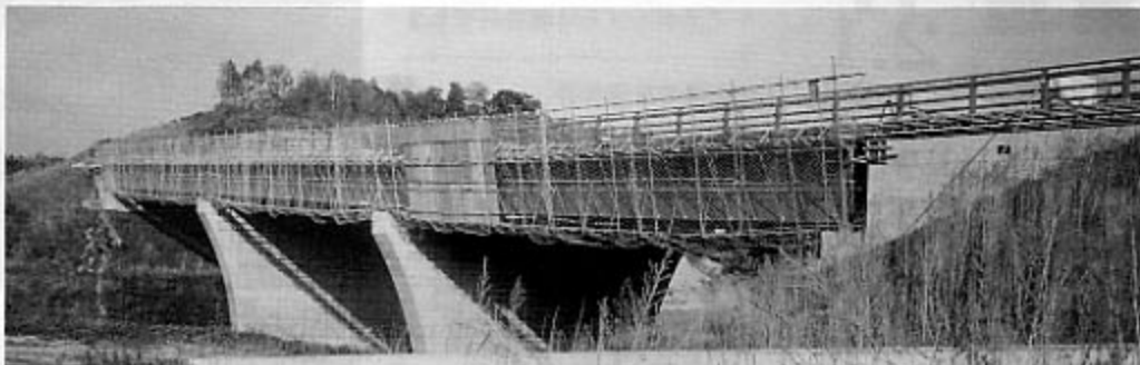
建設中の東陵大橋
