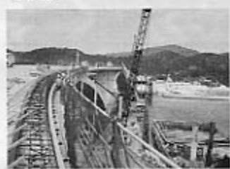
平成4年度に着工した阿嘉橋
