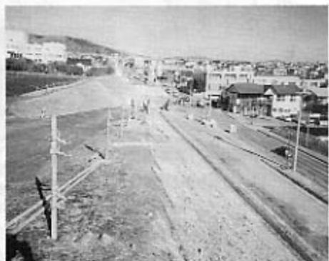
道路幅は平成11年完成
