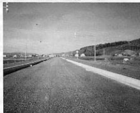
平成9年度工事完成(西19号～西20号間)
