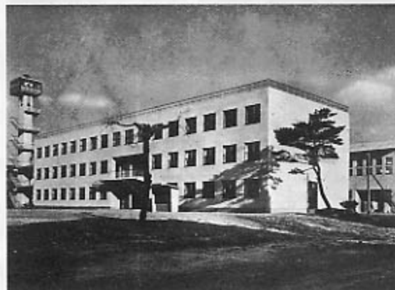
昭30 北見市役所庁舎完成
