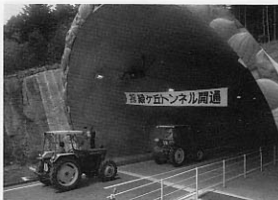
平8 緑ヶ丘トンネル開通
