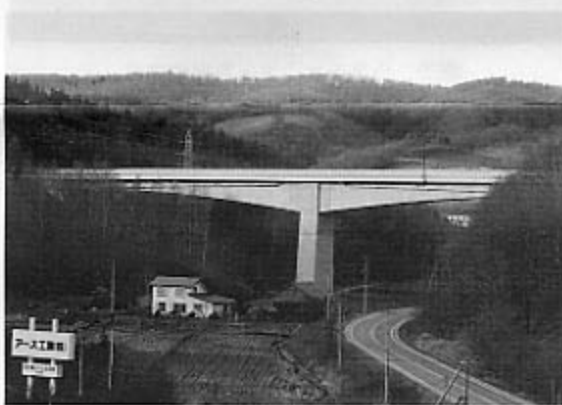
平2 平成高架橋完成
