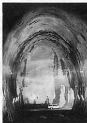
掘削が完了した久慈石油基地
