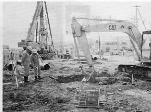
2重防錆タイプ工法の工事現場
