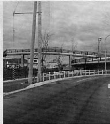
さくら跨線橋
