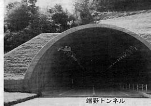
端野トンネル
