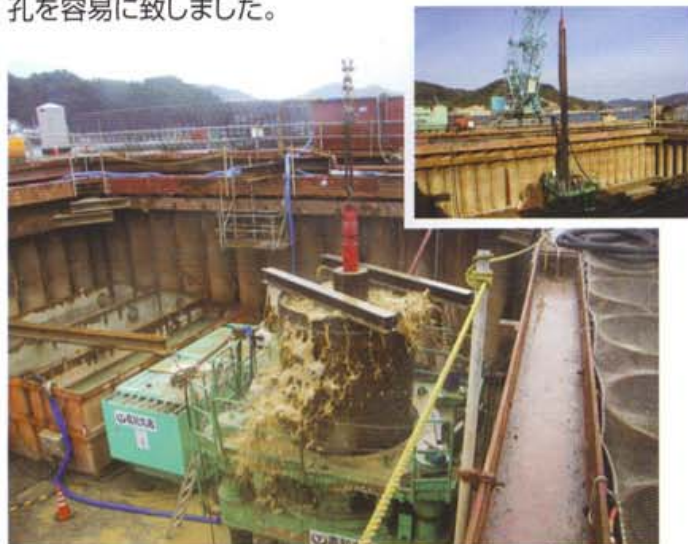
ダウンザホールハンマーの施工
