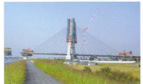
■矢部川橋の施工状況
