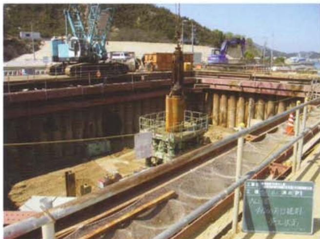
φ1200での先行施工
